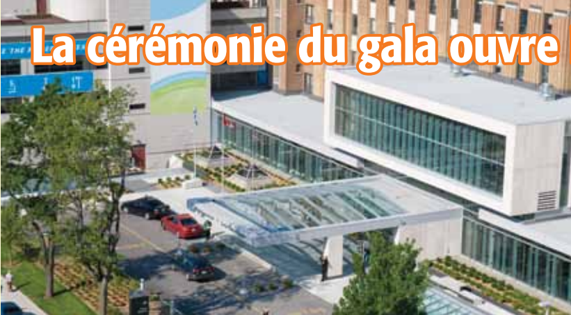
La nouvelle entrée, entièrement revue et rénovée.
